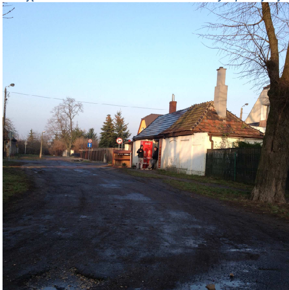
Zdjęcie 5. Gruntowa nawierzchnia ulicy Spokojnej.
